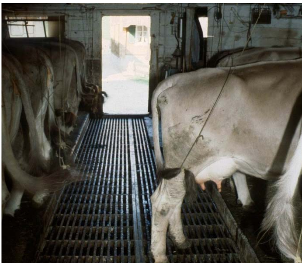
Fig. 10 Canale di evacuazione quale corridoio di stalla
