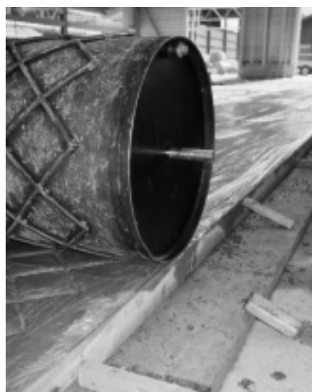
Fig. 10: Le profilage doit être effectué à la même vitesse que le bétonnage précédent. Grâce aux supports (coffrage et/ou rails de guidage), le rouleau peut rester sur la surface pendant les temps d'attente.
