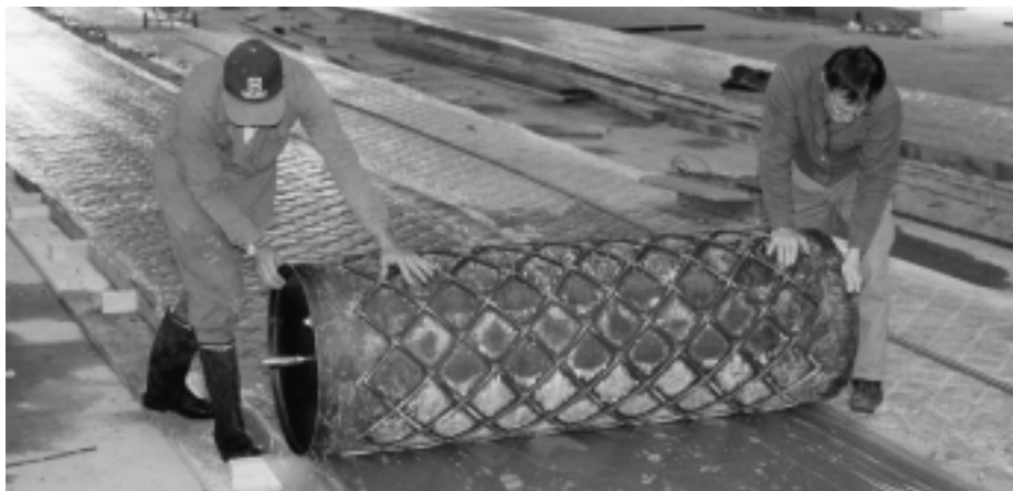
Fig. 11: Le rouleau métallique utilisé pour le profilage doit présenter un gros diamètre; un rouleau d'une dimension de 60 cm peut aisément être déplacé par deux personnes.
