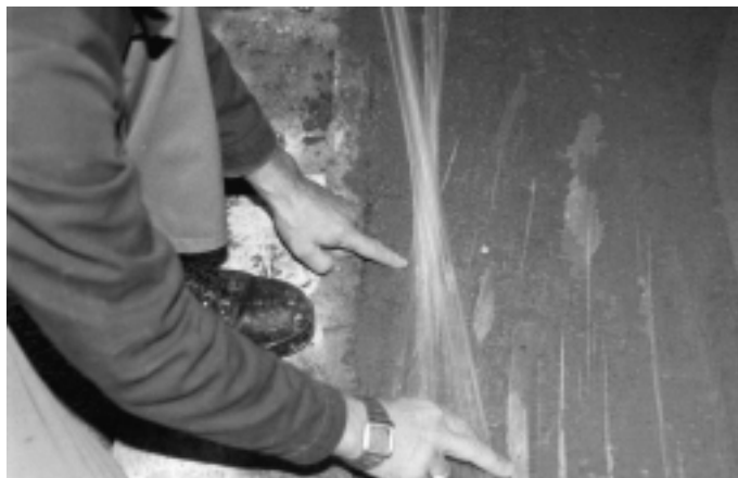
Fig. 8: Le moment pour profiler le béton est déterminé en testant avec le doigt. Ce moment peut varier considérablement en fonction des conditions de livraison et de pose.
