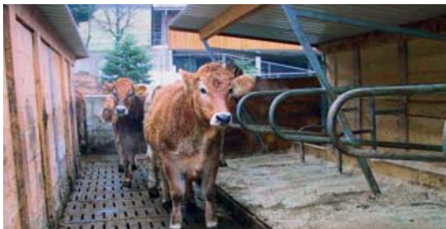
Fig. 8: Stabulation libre à logettes conçue selon le principe des abris à vélos (plusieurs rangées de logettes disposées parallèlement les unes aux autres); passages entre les rangées à la suite des surfaces de repos, aire d'affouragement dans l'ancienne étable.
