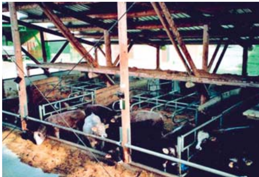
Fig. 13: Stabulation libre à logettes, sous la forme d'une étable non couverte (les portions ouvertes dans l'enveloppe du bâtiment sont pourvues de filets brise-vent); table d'affouragement utilisable des deux côtés; aires d'exercice et d'affouragement sur caillebotis (photo: bulletin Melior n° 90)
