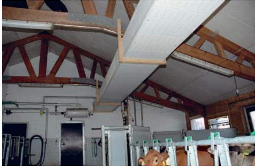
Fig. 17: Avec un canal de ventilation à panneaux perforés, l'air frais entre sans turbulence dans l'étable.
