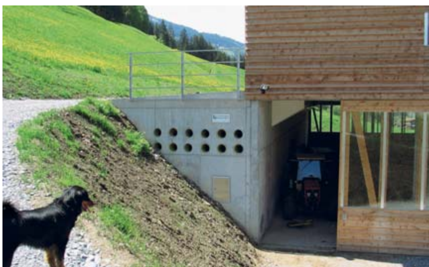
Fig. 23: Lorsque l'étable est construite sur un terrain en pente, il est possible d'utiliser le talus comme échangeur de chaleur souterrain.
