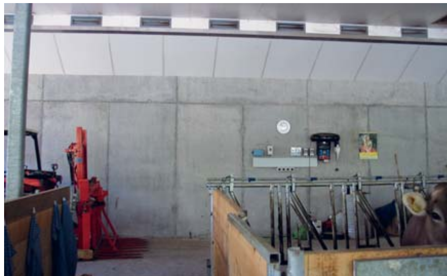
Fig. 15: Les ouvertures à la paroi devraient être placées le plus près possible du plafond (nu) pour tirer partie de l'effet dit de Coanda.
