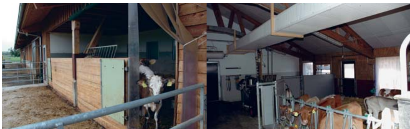
Fig. 1: Suivant le site, l'exposition et le bâtiment, il est préférable d'opter pour une aération naturelle (étable à front ouvert, à gauche) ou mécanique (canal de ventilation à panneaux perforés).
