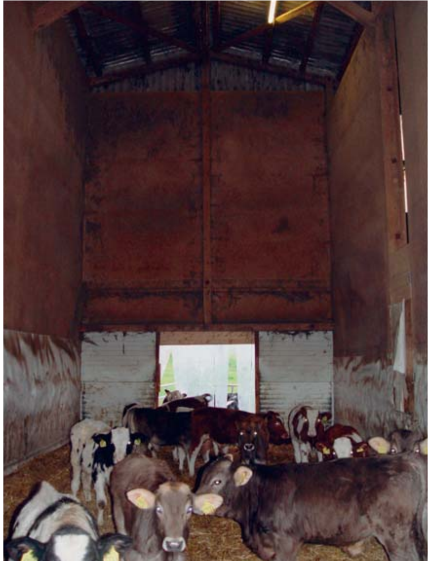
Fig. 7: Des couloirs d'air froid peuvent poser problème dans les hauts bâtiments et lorsque les toits ne sont pas isolés.
