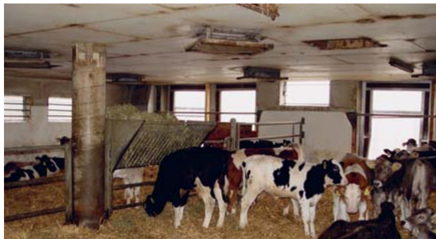
Fig. 16: Comme les ouvertures dans la paroi, les ouvertures dans le plafond permettent difficilement d'éviter les courants d'air.
