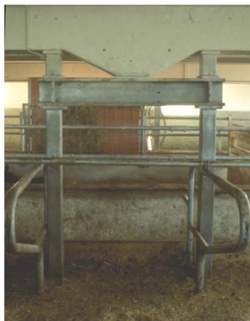
Fig. 21 Soutènement par double pilier, lorsque le plafond est particulièrement lourd (Freihofer, Zurich)
