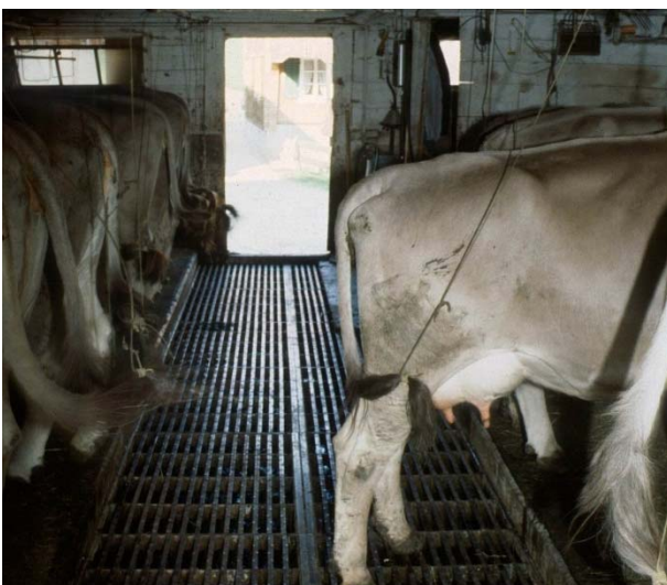
Fig. 10 Canal d'évacuation remplaçant le couloir
