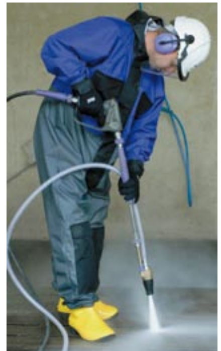
Fig. 10: L'utilisation du jet d'eau à haute pression nécessite le port d'une combinaison de protection complète. Une consigne correspondante est indispensable pour cette procédure.
