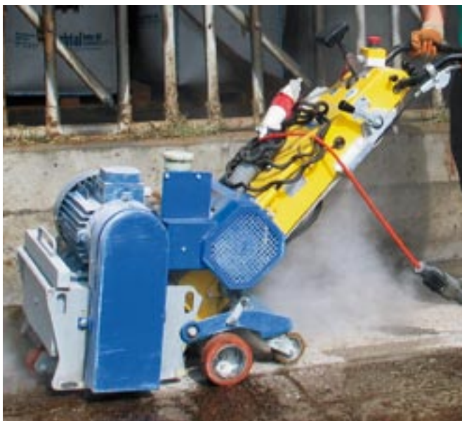
Fig. 4: Pour fraiser les rainures de manière homogène, il est nécessaire d'utiliser des appareils avec un mécanisme de translation réglable en continu. Le poids minimal des appareils et des outils ménage la structure du béton.
