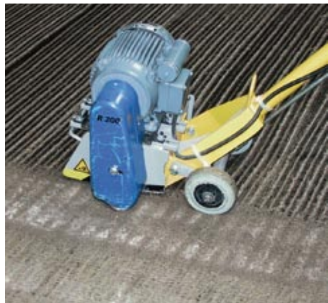
Fig. 5: Le décapage dans le sens de la largeur permet de travailler le reste de la surface. Cette technique augmente considérablement le caractère antidérapant du revêtement dans le sens de la longueur.
