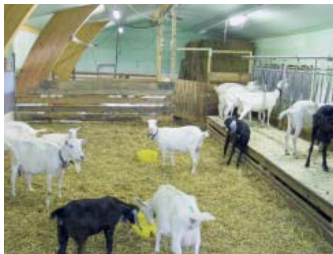
Fig. 2: Stabulation libre à deux aires fonctionnelles avec aire de repos recouverte de litière et aire d'affouragement surélevée.
