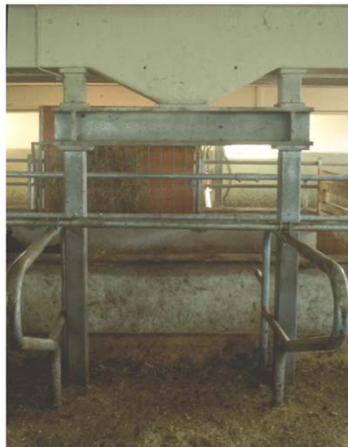
Abb. 21 Zweiseitige Stützen für hohe Deckenbelastung (Freihofer, Zürich)
