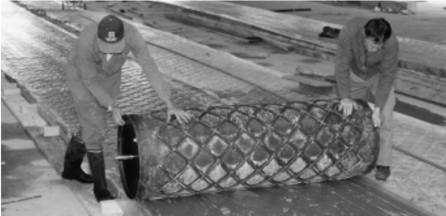
Abb. 11: Die Stahlwalze für das Profilieren muss einen grossen Durchmesser aufweisen; mit 60 cm lässt sie sich von zwei Personen recht gut vorwärts bewegen.
