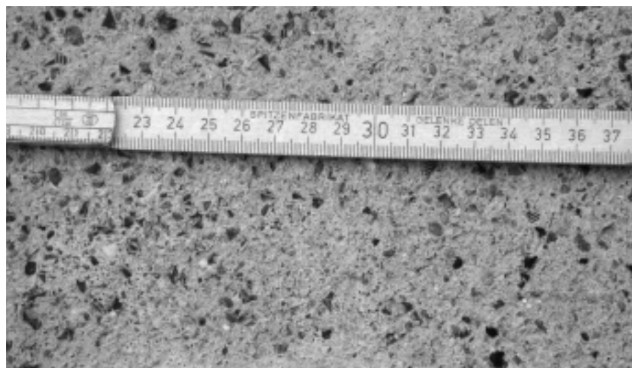
Abb. 7: In die oberste Betonschicht eingearbeitetes Gummigranulat: Um den Verschleiss zu mindern, muss die Entmistungstechnik schonend einsetzbar sein.
