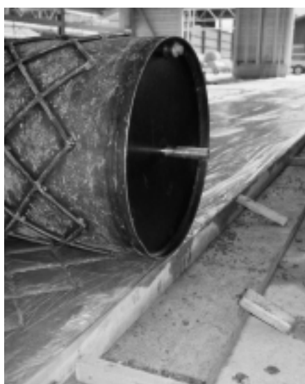
Abb. 10: Das Profilieren muss mit der gleichen Geschwindigkeit wie das vorgängige Betonieren erfolgen. Dank dem Auflager (Schalung und/oder Führungsschiene) kann die Walze während der Wartezeiten auf der Fläche verbleiben.
