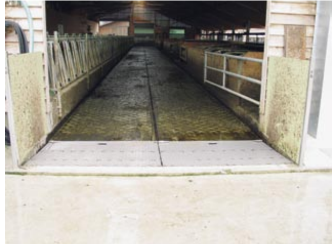
Abb. 19: Die Befahrbarkeit der Mistbahn erfordert eine Ausführung ohne Stufen und Absätze. Zum Beispiel können Überfahrbleche, die gleichzeitig als Umzäunung dienen, die Abwurföffnung während der Durchfahrt schliessen.
