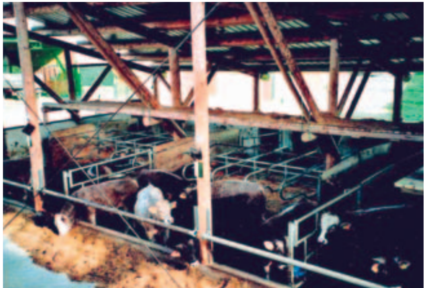
Abb. 13: Liegeboxenlaufstall als ganzflächig überdachter Kaltstall (offene Bereiche der Bauhülle mit Windschutznetzen versehen); Futtertisch beidseitig genutzt; Lauf- und Fressbereich als Spaltenboden gestaltet (Bild: Meliorbulletin Nr. 90)
