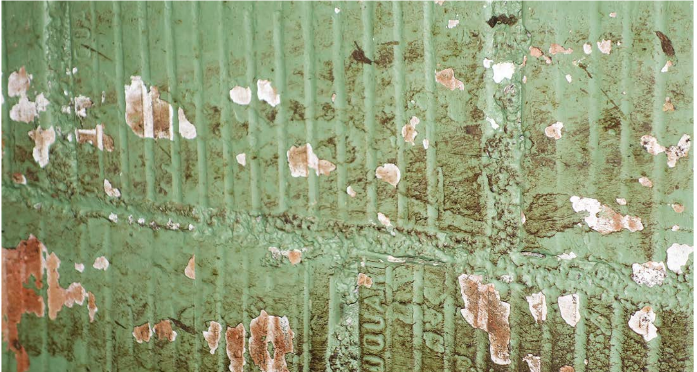
Beispiel von PCB-haltiger Farbe. Bild: EMPA.
