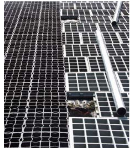
Sistema di griglie alveolari in materiale sintetico come fondo o strato intermedio (prima del riempimento ad es. con ciottoli)
